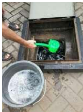
Gambar G Tangki Penampungan Air Wudhu
