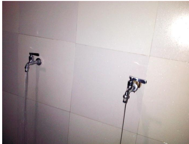
Perbedaan Laju Air Keran Dengan dan Tanpa Flow Restrictor
