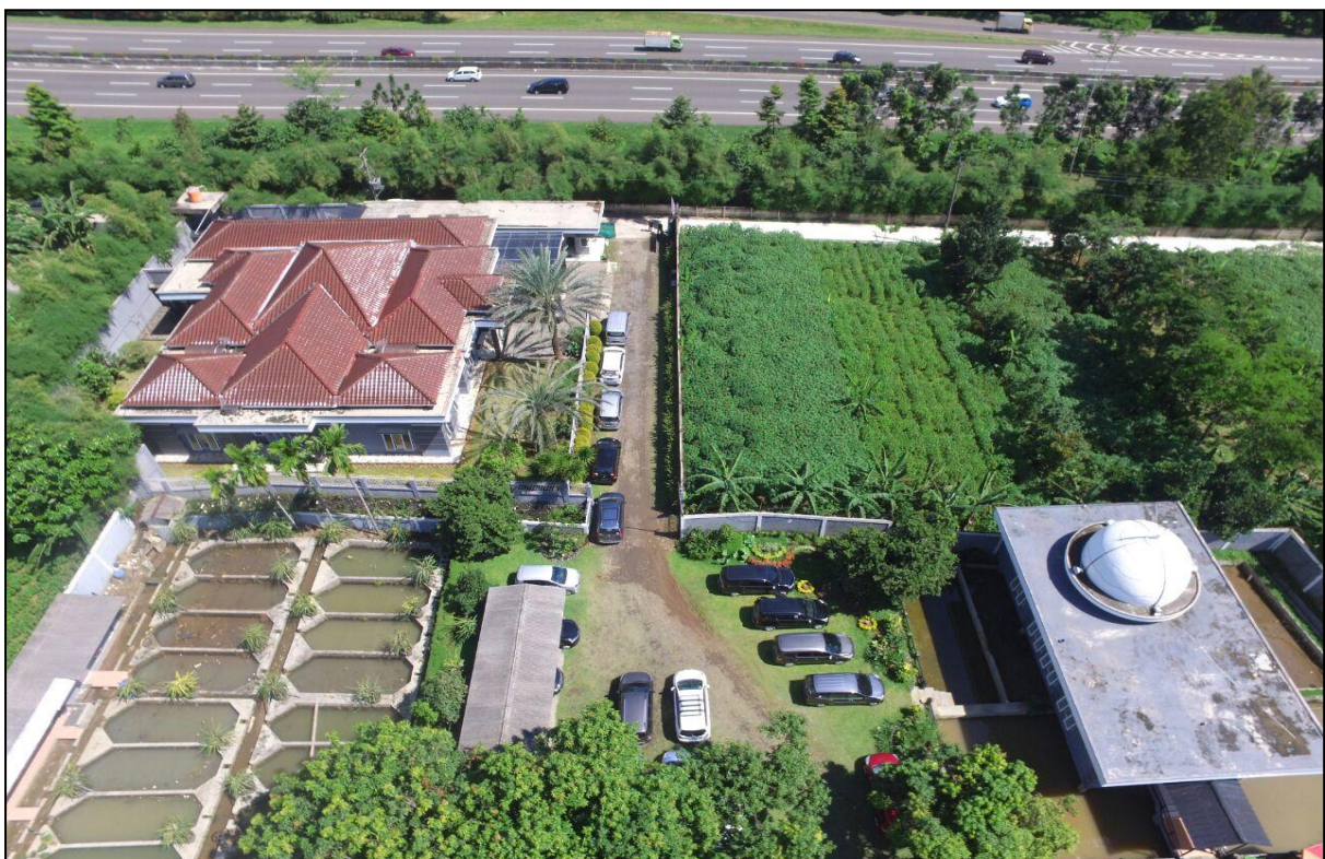
FOTO-2: Tampak dari Atas Lokasi PKM di Sentul Fresh, Bogor, Jawa Barat
