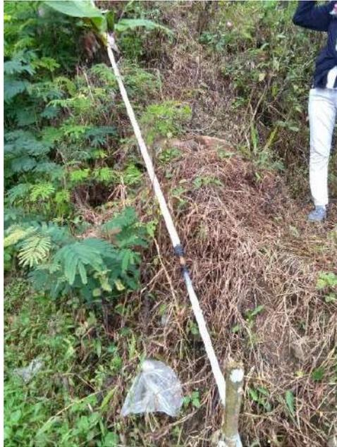
Gambar 22. Pipa Distribusi Air Bersih yang Tidak Tertanam di Tanah
