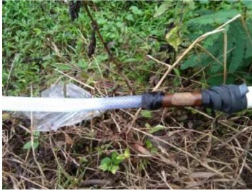
Gambar 23. Penghubung Antar Segmen pada Perpipaan Distribusi Air Bersih
