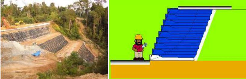
Gambar 5. Perkuatan Lereng dengan Geotekstil
