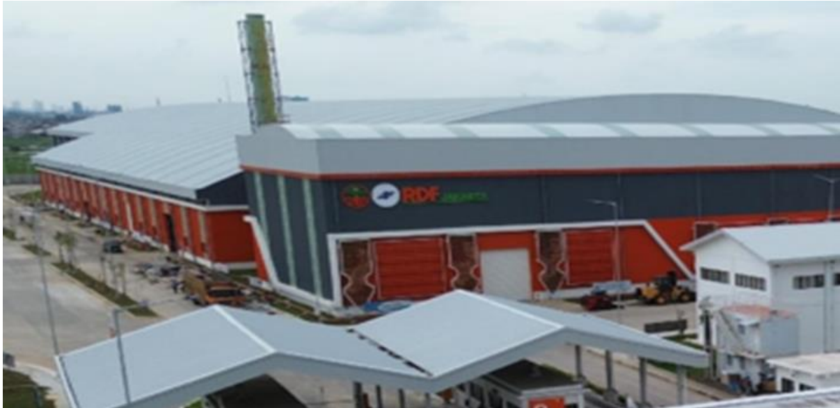
Gambar 8. Stack Sisi Utara Sumber : Dokumentasi lapangan
