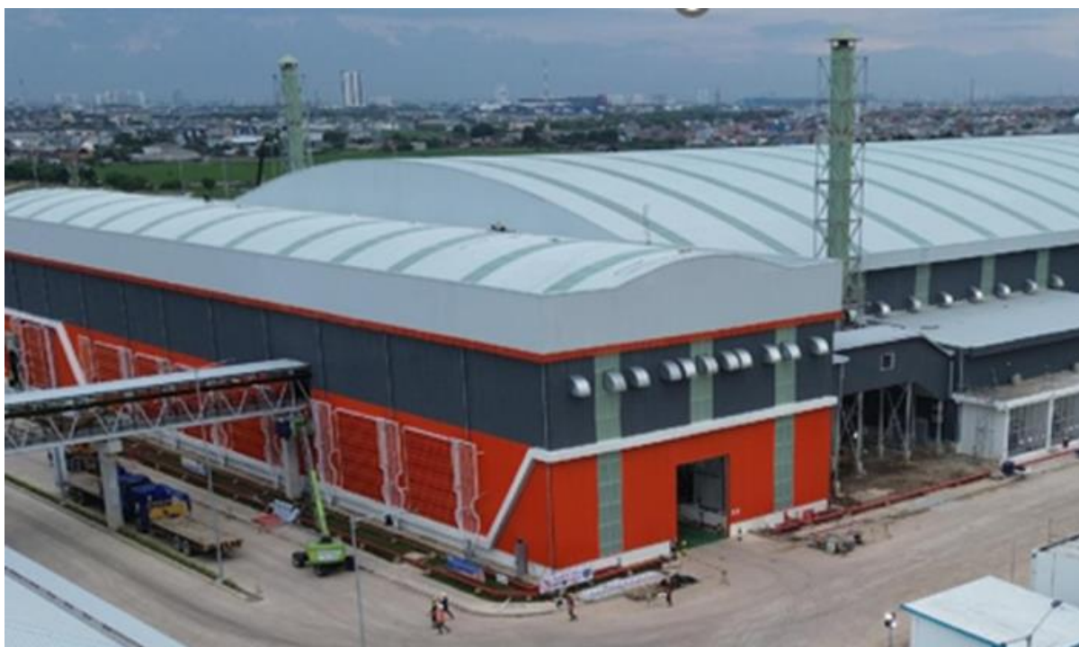
Gambar 9. Stack Sisi Utara Sumber : Dokumentasi lapangan
